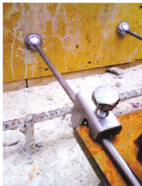
④鉄骨等からのセバ引
