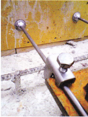
④鉄骨等からのセバ引
